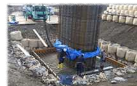
橋梁の耐震補強工事
